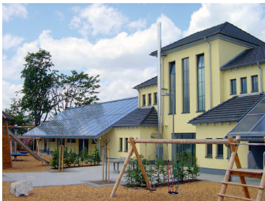
Bild 1 Wohnsiedlung „Am alten Schlachthof“ in Speyer
