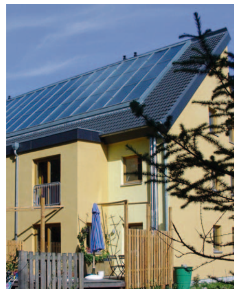
Bild 2 Ökologische Bausiedlung Hamburg-Bramfeld
