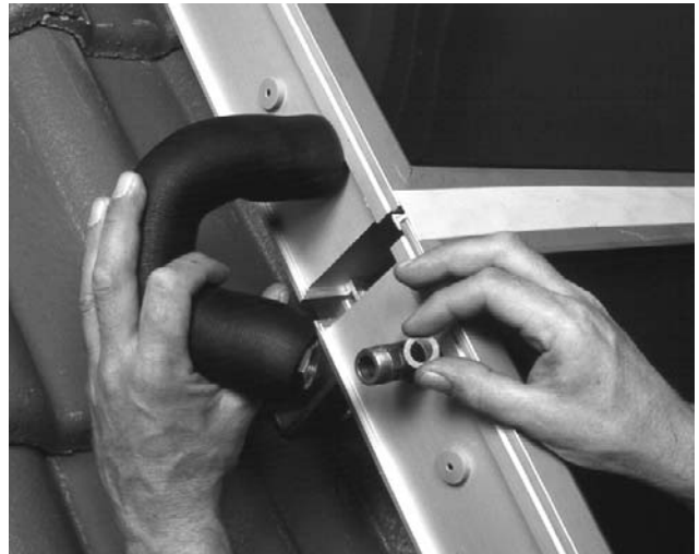
Bild 30 Förbind kollektorerna med vågrör av rostfritt stål. Beakta tätningsringarna
