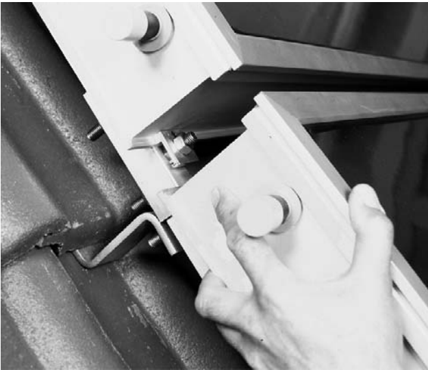
Bild 25 För den nedre kollektorn med ovankanten under fästklämmorna och skruva sedan fast de nedre fästklämmorna på sådant sätt att pilen pekar i kollektorns riktning.
