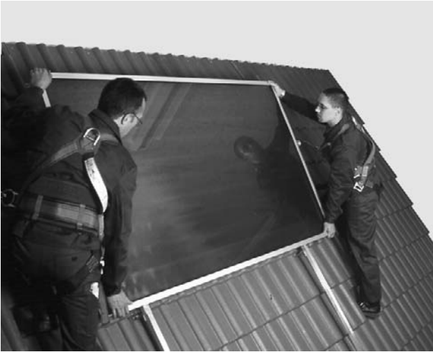
Bild 23 Sätt ned kollektorn på de båda nedre skruvbultarna på kollektorskenorna.
