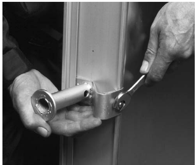
Bild 22 Bårgrepp levererar vi på begäran. Skruva fast på kollektorns båda sidor med fästklämmor - högre kil till kollektorn (se lupp bild 2). Kontrollera att allting sitter som det ska och hålls ordentligt på plats!
