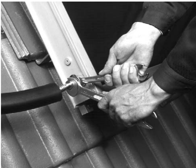
Bild 31 Håll emot vid åtdragning så skyddar du kollektoranslutningen mot skador. Korrigera röret eller ev. det förskjutna röret med en insexnyckel.
