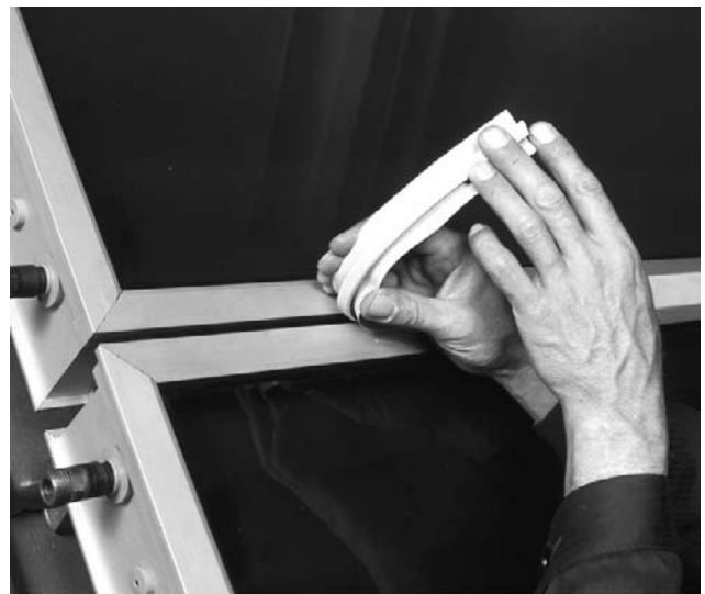
Bild 28 Tillval: för eller tryck in silikon-T-profil mellan två kollektorer.
