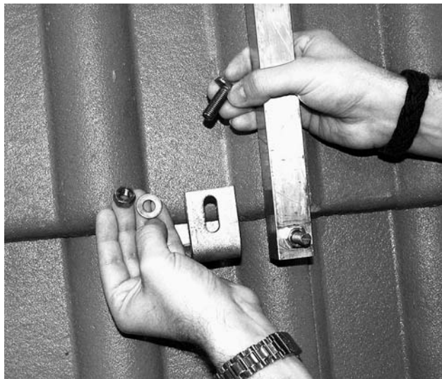
Bild 4 En säker takanslutning med monteringskena, hammarhuvudskruv och takankare (här beskrivs typen „P“ för Frankfurter-pannor och liknande former).
