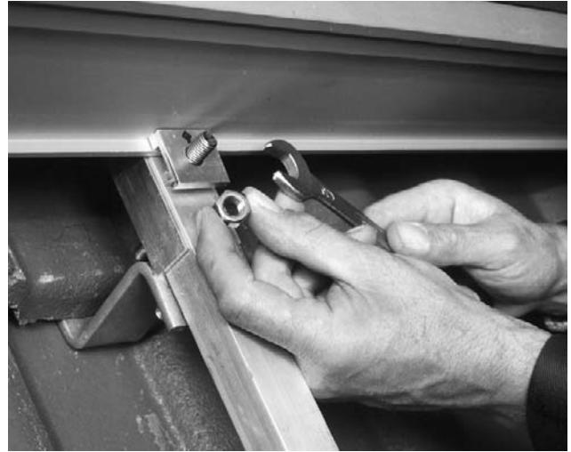
Bild 24 Fixera kollektorn på kollektorskenan på underkanten och ovankanten med fästklämmor på sådant sätt att den befintliga pilen pekar i kollektorns riktning (se lupp bild 2).
