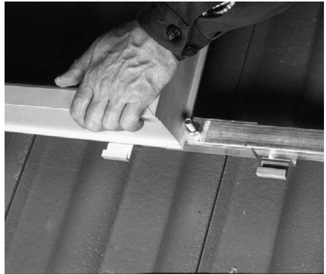
Bild 26 Endast vid lodrät anordning ska kollektorerna sättas in i takkolektorhållaren.
