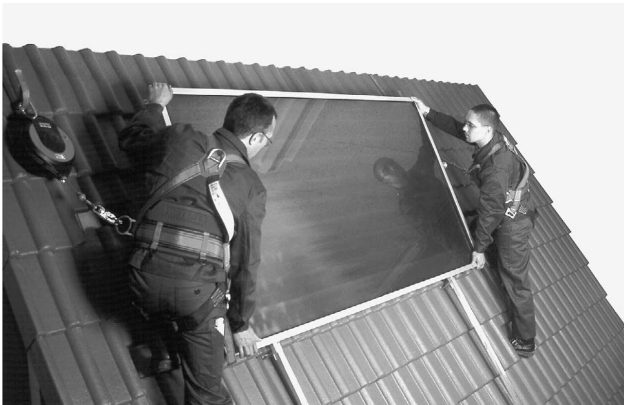
Bild 1 EURO-kollektorerna kan med taksystemet utan problem monteras med två personer, utan att man löddar och öppnar taket.
