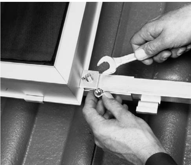
Bild 27 Fixera sedan kollektorerna på sidan med fästklämmorna på sådant sätt att den befintliga pilen pekar i kollektorns riktning. Placera nästa kollektor i kollektorhållaren och för den sedan under fästklämman.
