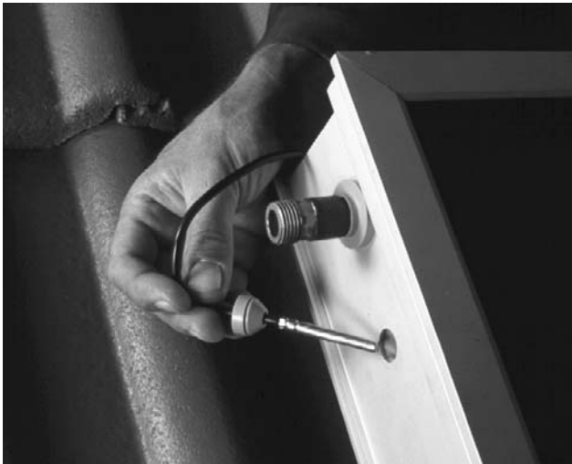
Bild 29 Dra propparna ur sensorhylsan och skjut dem på sensorn. Placera sensorn i absorberingshylsan (när det gäller EURO C22 i ramens mitt) och förslut den på nytt. Dra kabeln genom så kallat lufttegel till sensordosan.
